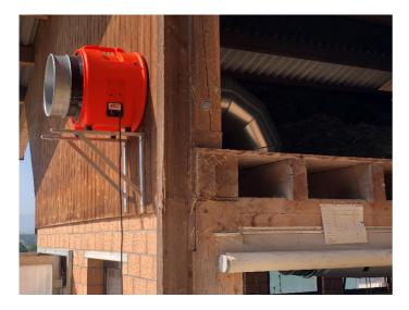
Le ventilateur est monté sur le mur extérieur et la puissance est adaptée au volume de l'installation.
