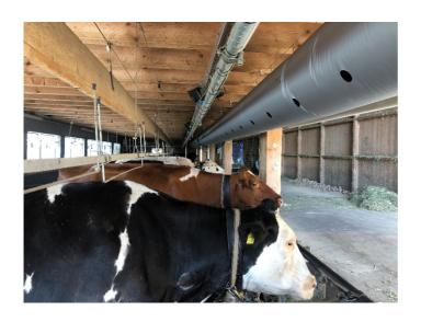
L'avantage du tuyau de ventilation est que l'air frais est guidé là où il est nécessaire et qu'il est distribué de manière uniforme. Ceci empêche certains animaux d'être exposés à des courants d'air excessifs tout en ne ressentant aucun effet de ventilation sur les autres animaux plus éloignés du ventilateur. C'est le plus grand avantage de la ventilation par tuyau, en particulier dans les étables de hauteur limitée.
