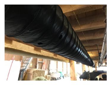
Selon les circonstances, un tuyau de conduit d'air avec une spirale à ressort à gaine peut être utilisé. L'avantage est que le tuyau reste dans la forme avec la ventilation éteinte et ne limite donc pas davantage la hauteur.
