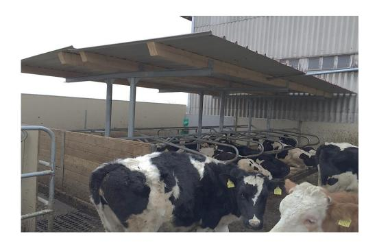
Überdachung Fressachse, inkl. Pfosten, Dachbalken und Sandwich-Trapezblech.
