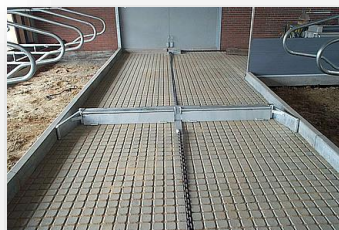
Entmistungsschieber mit Kettenantrieb
