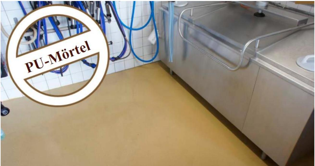
Eine weitere Besonderheit ist die sehr schnelle Montage. Der PU-Mörtel kann in einem Tag montiert werden und ist danach bereits nach wenigen Tagen einsatzbereit. Lange Wartezeiten entfallen.
